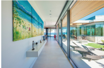
高さ3.3mのガラスのスライディングドアが設置された廊下。玄関ホールからLDにつながる。夏は2階のバルコニーが庇の役目を果たす。
