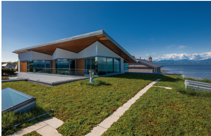
2階にはプライベートルームが3室並ぶ。手前の緑化された屋根に設置されているのはトップライト。
