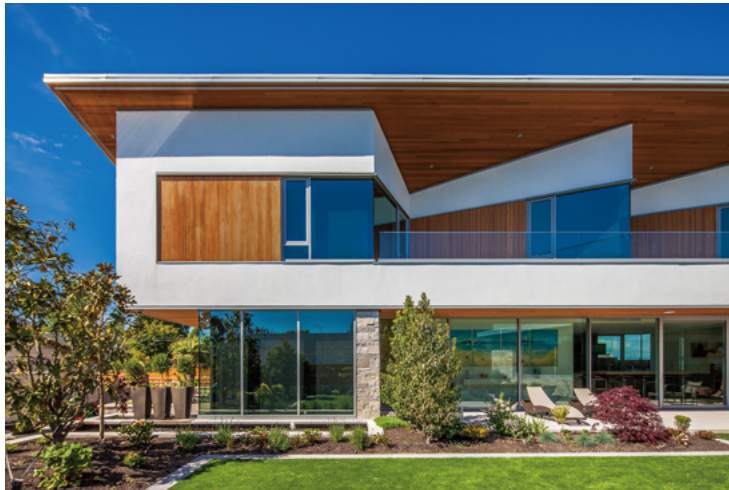
南側外観。ライムストーン、ウェスタンレッドシーダー、スタッコ、ガラスといった質感・色調の異なるさまざまな建材を使用し、凹凸やアングルをつけるなど先進的デザイン。
