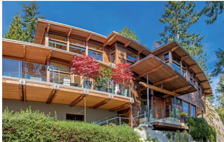
硬質な花崗岩壁に建つ住宅。太平洋沿岸の地域の建材を多用するとともに、地形線に沿って壁や屋根・屋上テラス床の輪郭をカーブさせ、景観に調和するデザインが考えられている。
