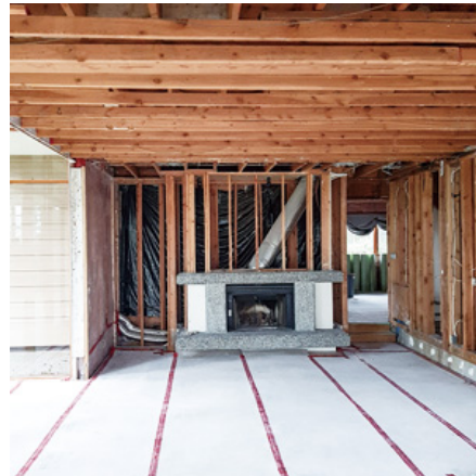
1階リビングのリフォーム工事の様子。70年以上前の構造材は優良状態だった。
