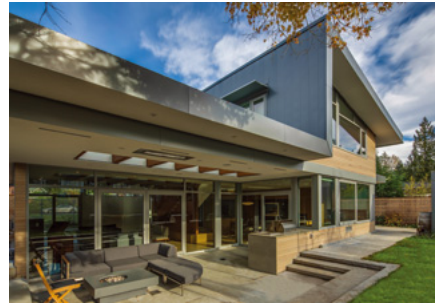
▲南側は窓を配し内と外が一体化する設計になっている。
