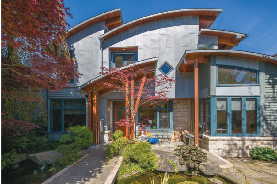
屋根材・外壁材には耐候性・耐食性に優れた鋼板を使用。金属と木材や石材の自然素材が融合した外観デザイン。
