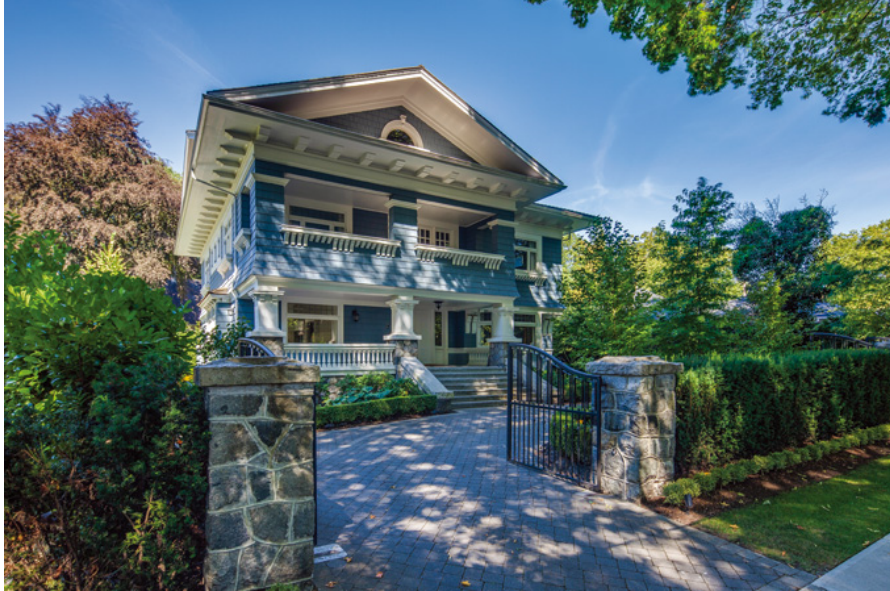
▲110年を経て甦ったファサード（東側）
