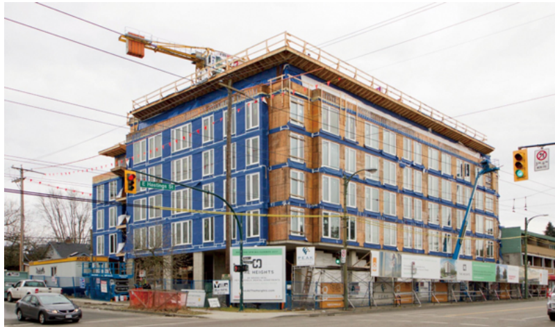
建設中の6階建て賃貸マンション。壁は35cm厚の二重構造になっている。。
