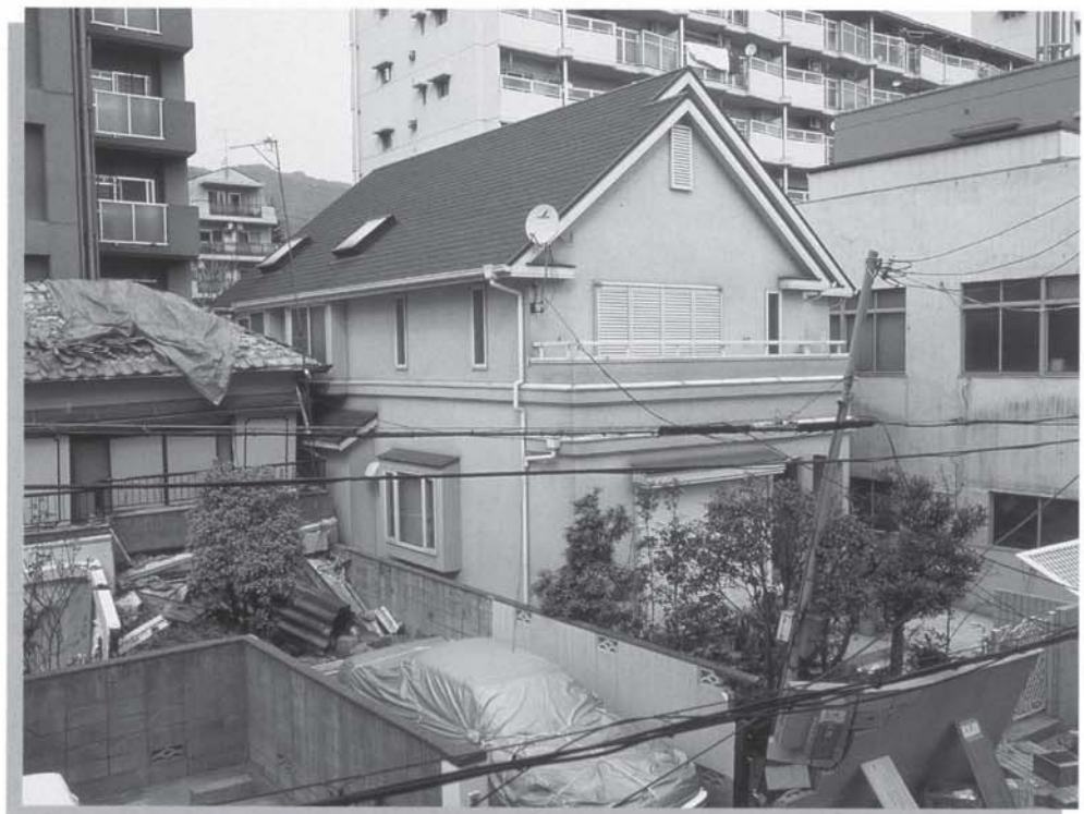
神戸市灘区O様邸。周囲の建物が全・半壊しているなか、リビングのクロスがはがれる程度という軽微な被害。「耐震性の高いツーバイフォー住宅を選択した正しさをあらためて実感した」という(阪神・淡路大震災)。
