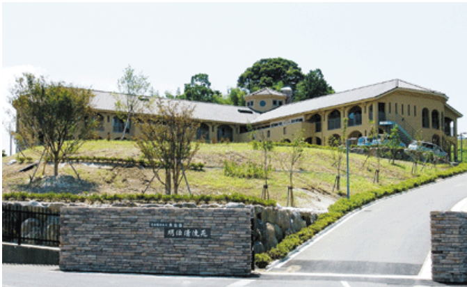
▲エントランスから丘の上にゆったりと佇む建物を見上げると、左右にのびるユニットが両手を広げているように見え、そのやさしい表情に心がやすらぐ
