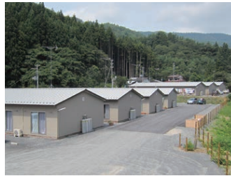
写真8 宮城県女川町に建設された被災者のための応急仮設住宅。
