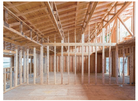
写真7 千葉県富津市に建設された幼稚園。千葉県産材のスギの枠組材が用いられている(写真提供：三井ホーム)。
