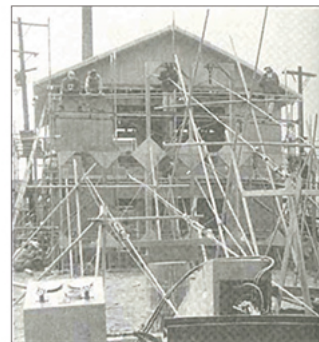
写真1 永大ハウスED構法(ED型)の実大実験
