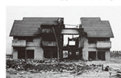
写真1 小屋裏利用3階建て タウンハウス構造・火災実験
