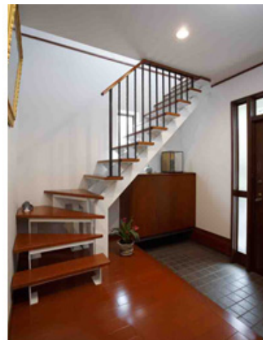
1階玄関。新設の階段は鉄骨製だが、木の踏み板、アイアンの手すりです既存空間に調和させている
