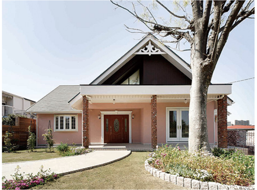
▲正面外観。既存の建物に浮き妻飾りや化粧モールを加え、外壁をサーモンピンクに塗り替えて輸入住宅の雰囲気を実際立たせている
