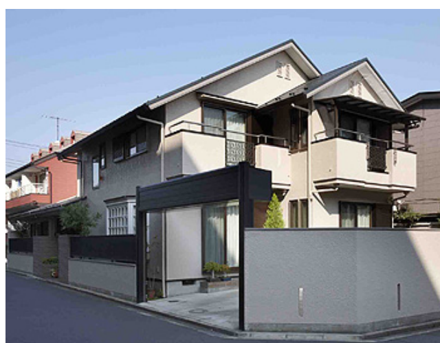
外装は全体をリフレッシュ。ちょうど築20年目の定期点検の時だったので、外壁の塗り替えやサッシ交換に加え、屋根診断、床下の防蟻処理も実施した
