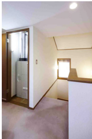
▲2階の納戸を改装して全館空調システムの室内機置き場を確保。室内機は1台のみで、サイズはコンパクト。温度は部屋ごとに設定ができる
