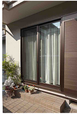
▲南面のサッシは遮熱・断熱・防犯ペアガラスサッシに交換し、セキュリティも向上
