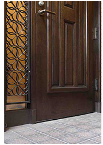
▲お気に入りだった玄関ドアは交換せず、エアタイト金具で隙間風の進入をブロック。気密性は大幅に向上した
