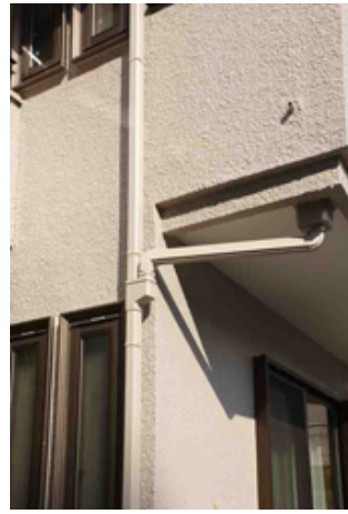
▲建物の性能を長く保つため、外壁の塗装と合わせて雨樋もすべて交換
