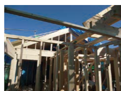
屋根と2階壁の解体後、高さを確保した壁と小屋を組み上げた。ツーバイフォーの構造を熟知したリフォームである。
