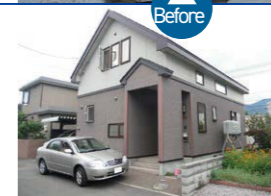
北側道路から見た外観。
