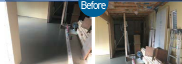
親世帯の水廻り・和室をカフェの厨房・客席へとリフォーム中。ベタ基礎スラブを床にした。
