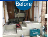
ガレージの入り口を後ろに半間下げて美容室へのアプローチ階段とした。
