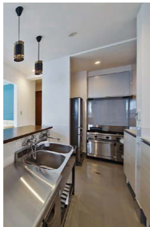
業務用設備機器が設置された厨房。床は客席よりさらに20cm低くなっている。配管スペースは厨房のカウンター下に配置されている。
