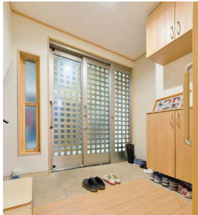
室内、ホールから土間、玄関ポーチへと、床は段差なくフラットに続くので、車いすのまま外出することができる。
