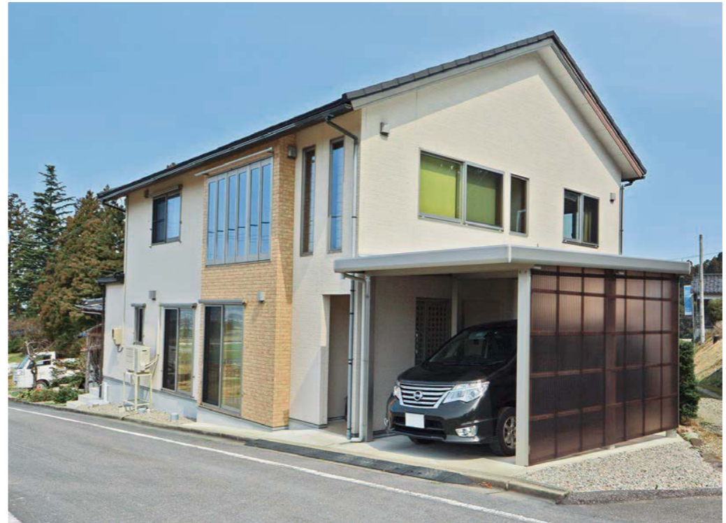
傾斜地に建っているため、リフォーム前、玄関ポーチは階段になっていた。そこで今回、車いすの使用を考慮して道路からフラットにアクセスできるように、一番高い位置に移設された。車庫は、南東部分を減築してつくり、撤去されたユーティリティは南西側を増築して設置された。
