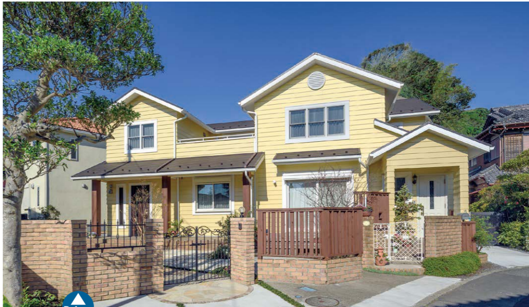
既存部分と増築部分(カバードポーチのある左側)が一体となった外観。既存の外壁と同じラップサイディングを採用し、ポーチ柱や庇で接合部が目立たない工夫がされた。
