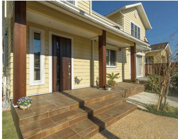
手前側(西側)が増築部分。事務所専用の玄関が新設された。玄関ポーチが既存住宅(奥)のリビング前のデッキとつながっている。
