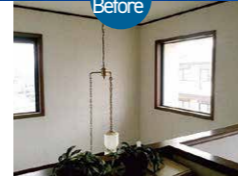
玄関上部は吹抜けになっていた。
