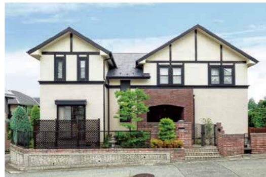
外観は2つの切妻屋根が特徴。1邸では新築以来、定期的なメンテナンスが施されてきた。
