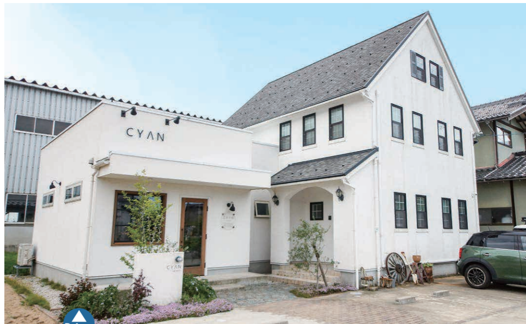
2階建て住宅の東側に美容室を増築。平屋なので既存住宅の2階への採光・通風が妨げられない。増築にともない、住宅のサッシの色を赤からグレーへ塗り替えた。
