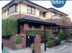
築21年のツーバイフォー住宅の躯体は堅牢で住み継ぐことが可能だった。
