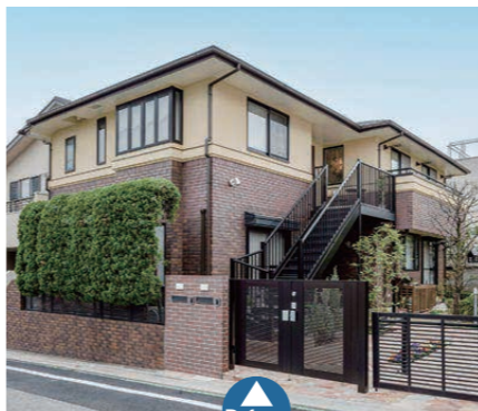
下屋をなくして外階段を設けて二世帯住宅へ生まれ変わった。門扉やアプローチもリフォームした。
