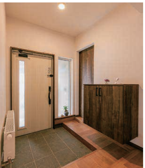
土間とホールの間の引違い戸が外され広々とした玄関。式台によりクロゼットへの出入りがスムーズになっている。
