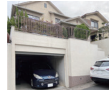
リフォーム前のA邸。高台の立地で前面道路は急勾配、住宅の下にはカルバートの掘り込みガレージがある。
