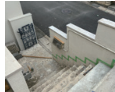
工事前のアプローチ部分。道路入口から玄関ドアの高さの割付は、実際に現場で仮の壁をつくり、絵を描いて何回も確かめながら改修案を決定した。
