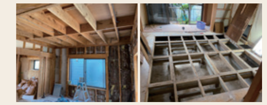
上：築35年と年月を経た住宅にもかかわらず、床・壁とも構造体はきれいな状態だった。下：浴室部分。排水づまりがリフォームのきっかけとなった。
