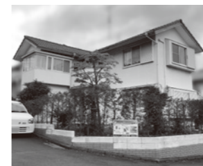
リフォーム前。窓はシングルサッシで開口面積が広がったため、冬場の結露が悩みだった。
