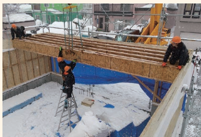
長尺を利用したTJI。スパンを飛ばせる利点から福祉施設や店舗などでの施工実績が増えている。
