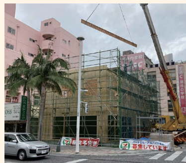
沖縄・那覇市の国際通りに建設中の耐火2階建てのコンビニ。上棟の早さが注目を集めた。
