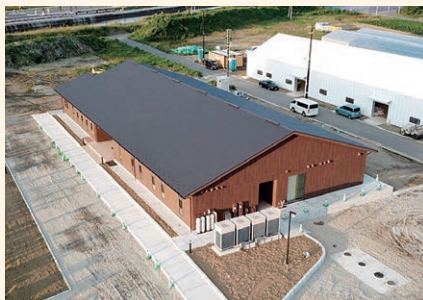
東日本大震災の復興事業として計画された農園施設兼倉庫。
