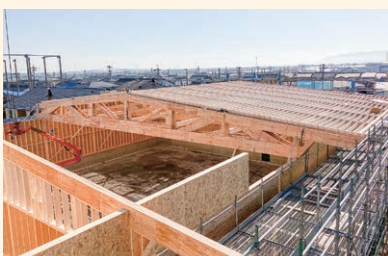
アルミ加工会社の新工場の施工風景。LVLトラスの採用で25.4mのロングスパンが実現した。
