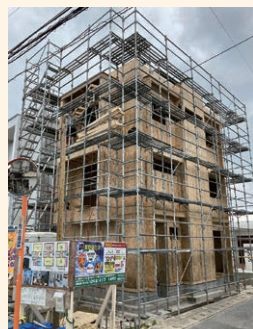
沖縄県の会員会社との連携による3階建て建売住宅。
