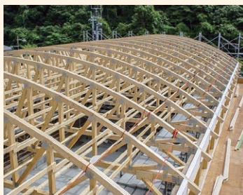
幼稚園の建方工事。アールの屋根をかたちづくるボウストリングトラスを施工。
