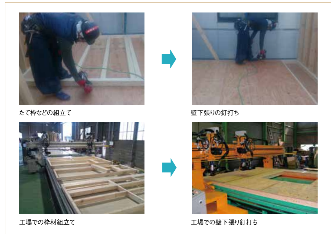
【図7】 壁枠組の製作（上：現場組立て、下：工場組立て）
