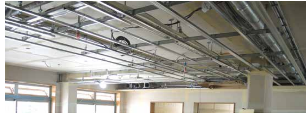
設置された鋼製天井下地。吊りボルトの受金物は天井根太の底に留付け
