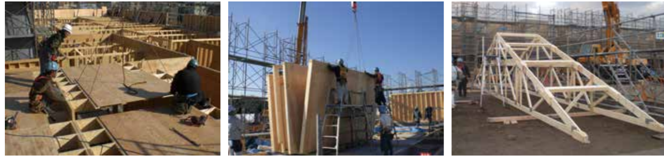
床枠組パネルの建込み
