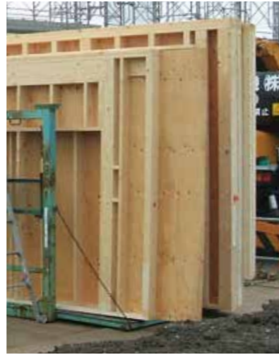
【図3】 壁の枠組の例 (910mmのプランニング・モジュールに対してたて枠を455mm間隔で割付け)
