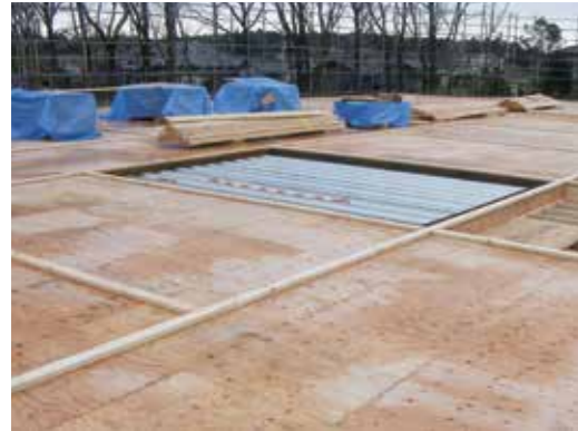
床枠組とコンクリート床下地 (デッキプレート)
