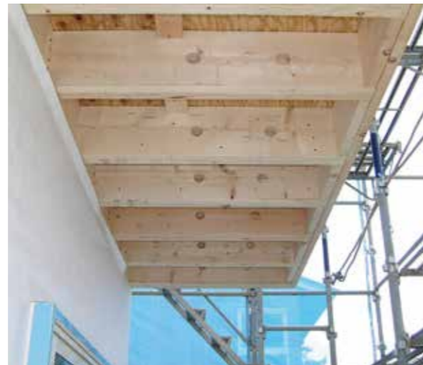
【図8】 床根太のはね出し
