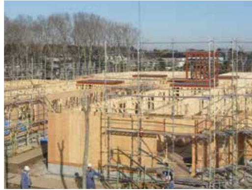
鉄骨架台の周囲に壁枠組を建方
