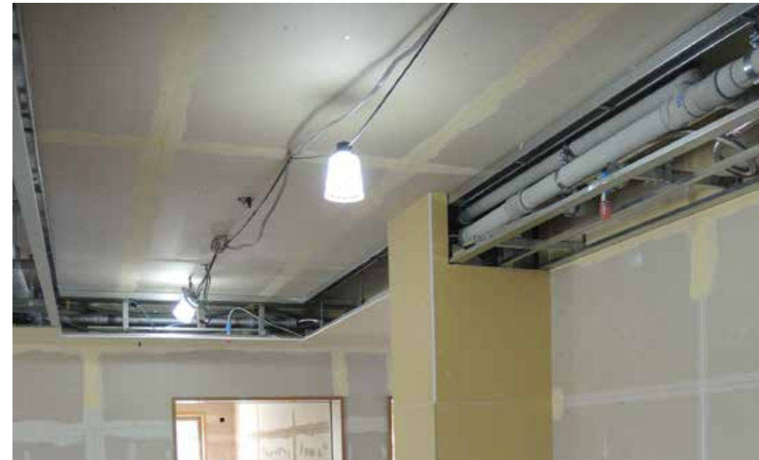
配管経路が設けられた壁際のみ吊り天井を設置
