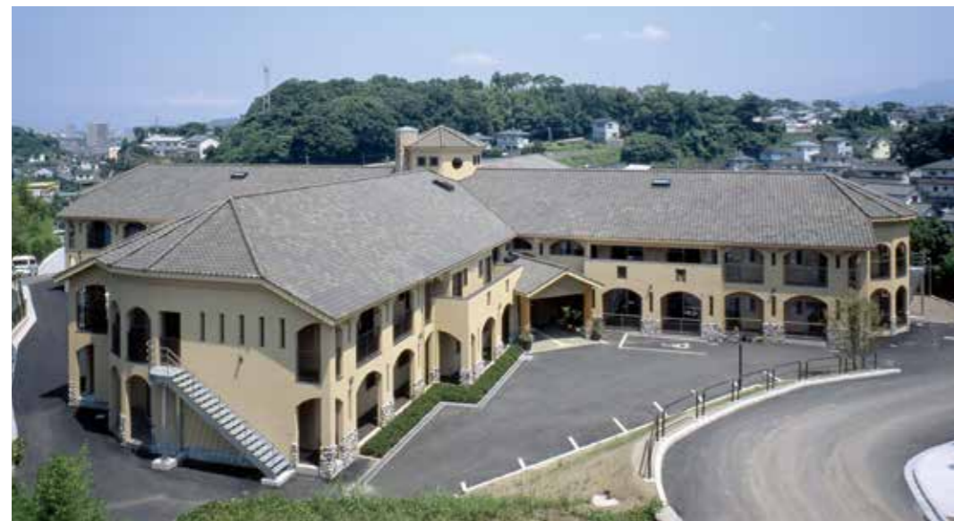
明治清流苑（設計：株式会社吉高総合設計） 49 床の特別養護老人ホームに、ショートステイ（11 床）とデイサービス（定員 30 名）が併設されている
