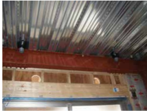
コンクリート床下地 (デッキプレート) の見上げ
