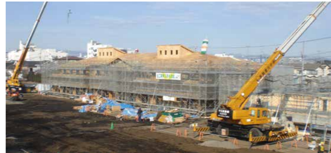
北棟は建方完了（左奥）。管理棟は1階の建方中（右奥）。西棟は根切りの準備中（左手前）
