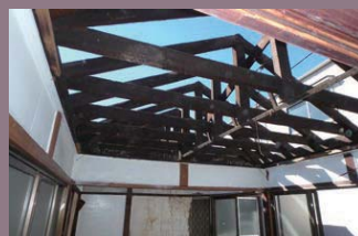
図6・図7 同潤会が建設した木造長屋のひとつ「荏原普通住宅」。小屋組の部材には、板材が使われている。(志岐祐一撮影)
