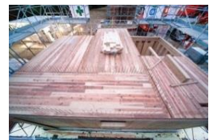
2階CLT床(工事中)
