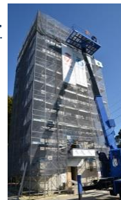
実験棟(工事中)
