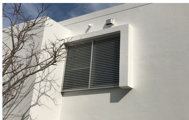
写真 2.2.5 台風対策を兼ねた開閉式ガラリ
