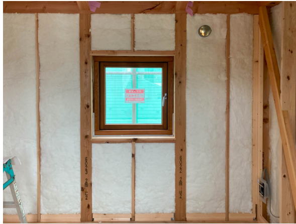
写真 4.2.3 開口部まわりの断熱施工
