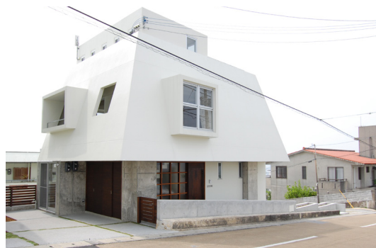
写真 3.6.4 屋根、壁面に遮熱塗料を塗布
