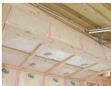
写真 4.2.5 断熱材の施工が完了
