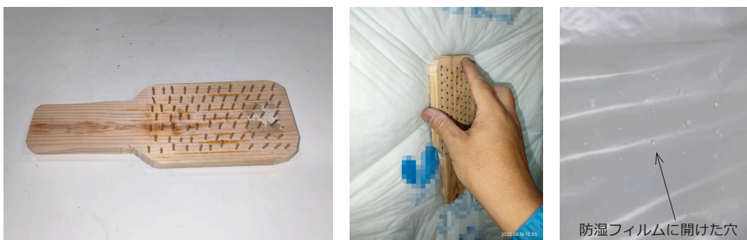
写真A 防湿フィルムに穴を開ける加工
