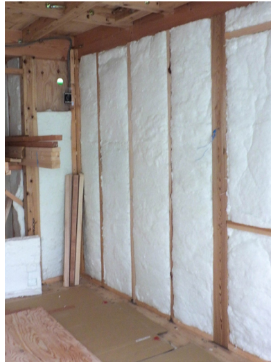
写真 4.2.1 外壁の断熱施工
