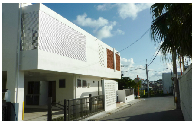
写真 2.2.3 通風・遮熱軽減・台風対策等を同時に行うルーバー・花ブロックによる日射遮蔽の事例
