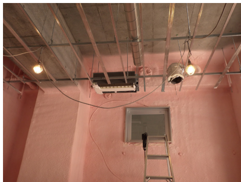
写真 4.3.1 吹付け断熱工法の施工例
