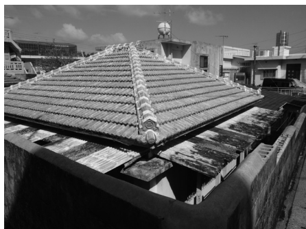
写真 2.1.7 密集した敷地に建てられた住宅
