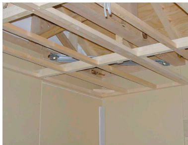
写真 4.2.4 天井の野縁の施工
