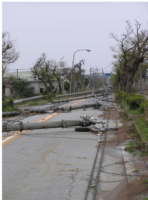
写真 1.2.1 2003 年の台風 14 号マエミー被害状況
