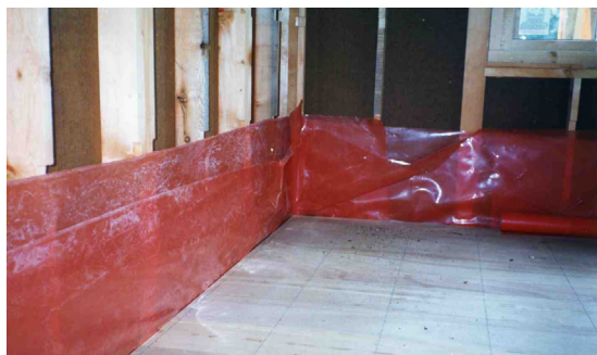
写真 5.2.1 先張り防湿フィルムの施工例
