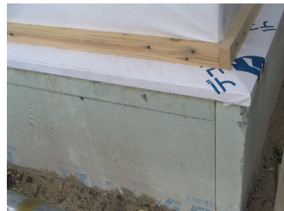
写真 5.1.2 基礎断熱の施工例
