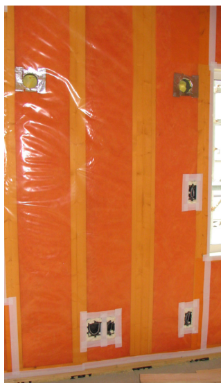
写真 5.5.4 コンセント部などの気密化例
