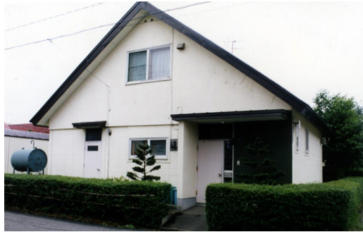
写真 2.1.3 コンクリートブロック造の住宅
