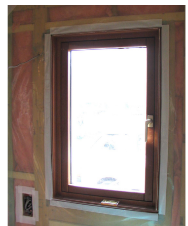
写真 5.6.1 開口部の気密化例
