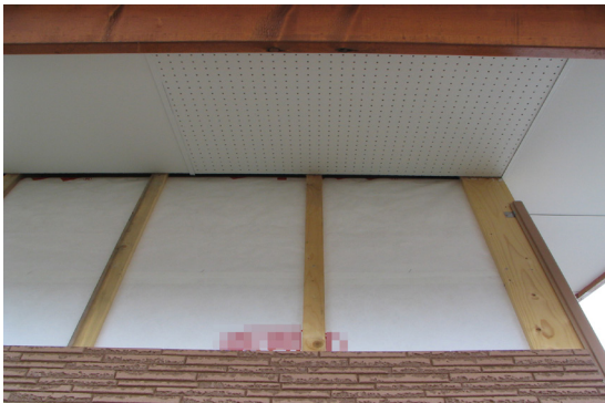
写真 5.1.3 縦胴縁と軒天部の納まり例
