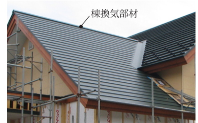
写真 5.1.5 棟換気併用軒天換気方式の例
