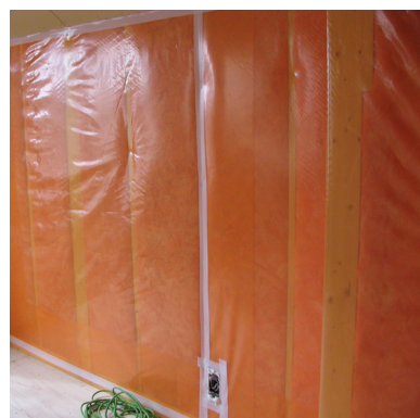
写真 3.2.2 防湿フィルムの施工例
