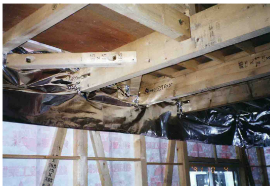
写真 5.2.2 先張り防湿フィルムの施工例 1
