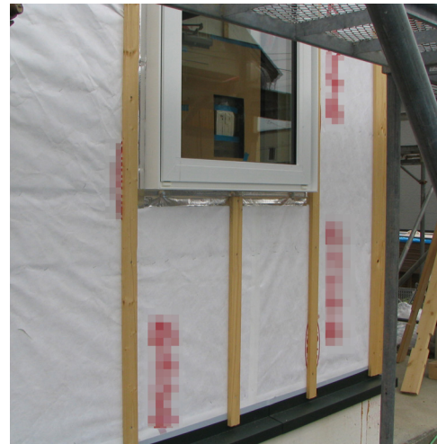
写真 5.1.4 縦胴縁による通気層の施工例
