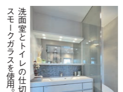
洗面室とトイレの仕切りにはスモークガラスを使用。
